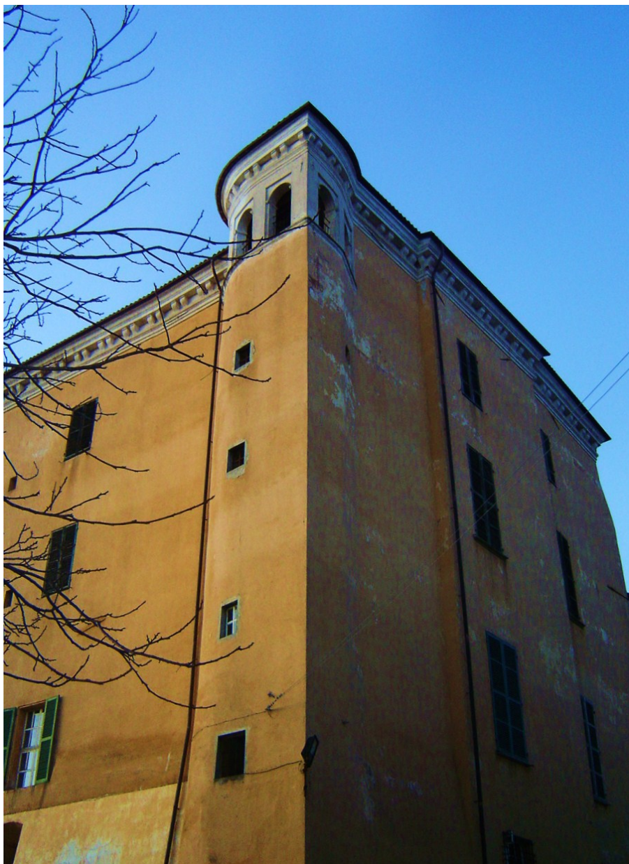
Vista del castello vecchio da sud
