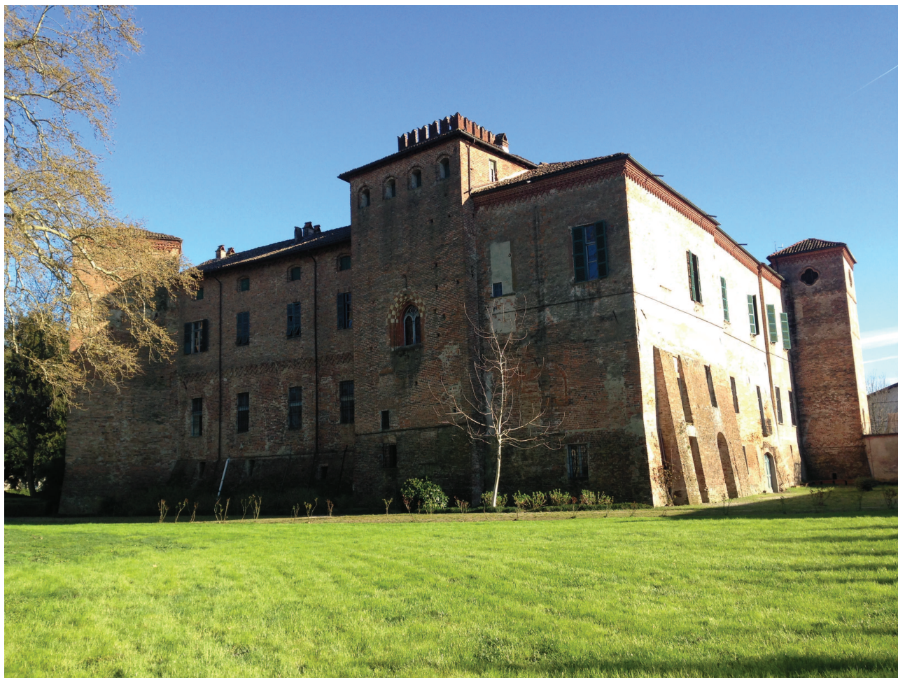
Facciata sul giardino
