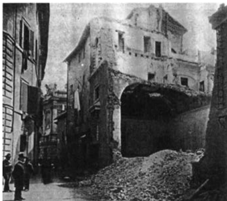
Demolizioni in via del Consolato in occasione dei lavori per l'apertura di corso Vittorio Emanuele II (15 febbraio 1888)
