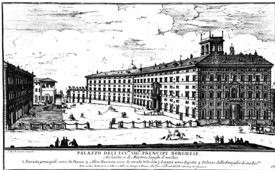
Palazzo Borghese da nord-est, da G.B. Falda-A Specchi. Nuovo Teatro, IV, 13 (1699)
