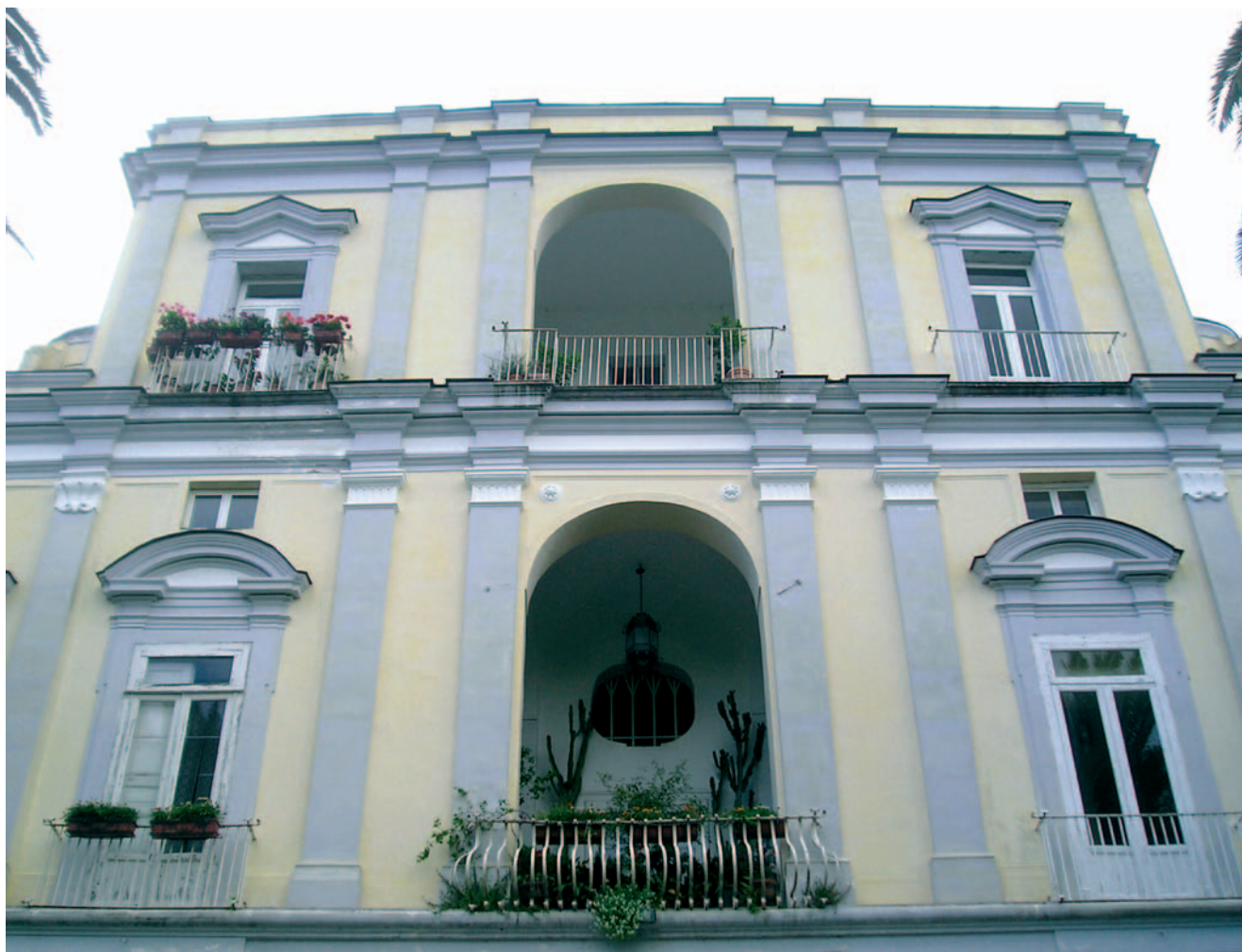
VILLA PATERNO', NAPOLI - La severa facciata neoclassica.
