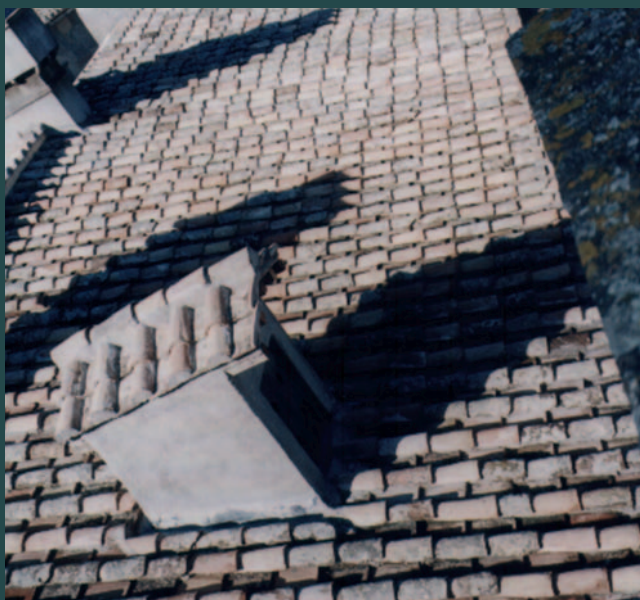
BRACCIANO, CASTELLO ODESCALCHI - Tetti di tegole
