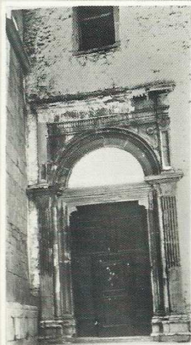
Il portale della Chiesa di S. Marco Ev. prima del restauro
