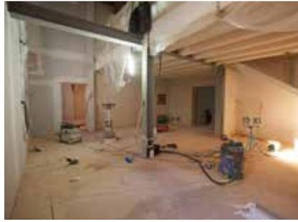
Posa del sistema di riscaldamento e raffrescamento radiante con successivo getto di pavimento in cocciopesto per la formazione di massetto caldo. Levigatura del massetto caldo in cocciopesto e finitura del cappotto interno.
