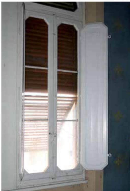
8. Le persiane esterne permettono di modulare la penetrazione dei raggi solari cercando di sfruttarli nella stagione fresca e respingerli in quella calda. 8. *The external shutters allow to modulate the penetration of the solar rays trying to exploit them in the cool season and reject them in the warm one.*
