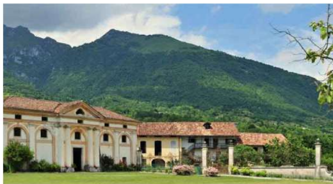
Villa Zugni Tauro de Mezzan – Feltre
