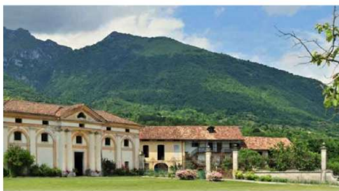
Villa Zugni Tauro de Mezzan - Feltre
