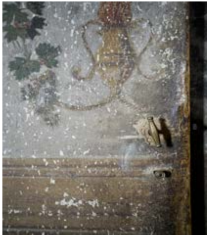
Porta di accesso allo studiolo di Fausto Franco dettaglio (foto degli autori)
