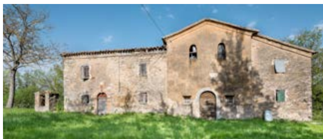
Prospetto principale del complesso di Mandra
