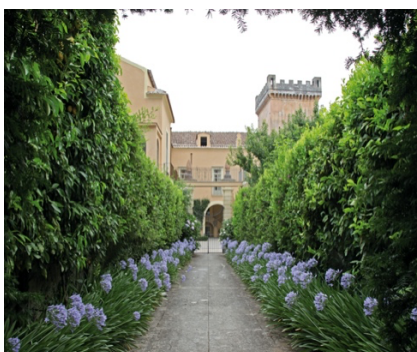
Ingresso al Giardino Guevara
