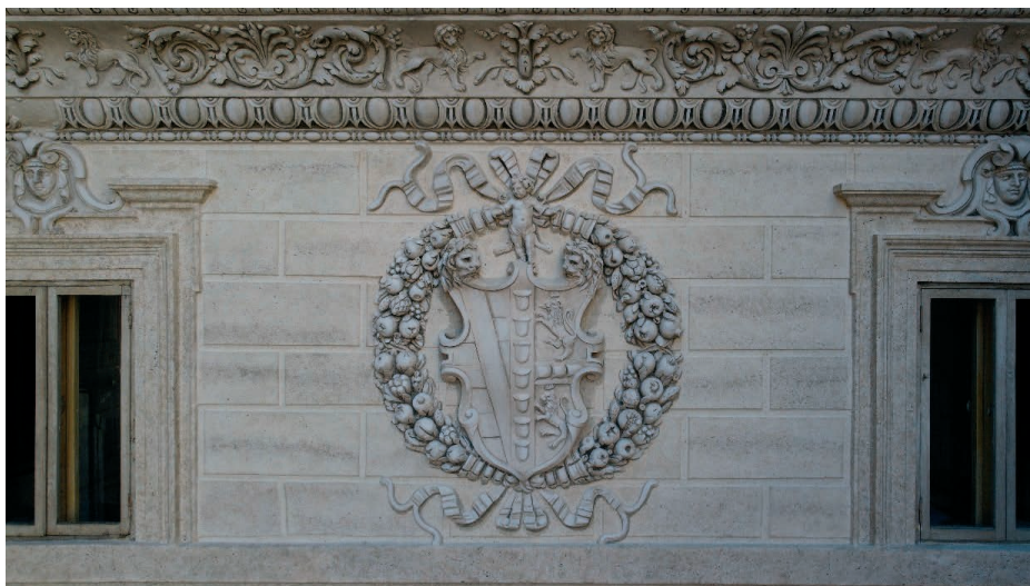
Particolare di una facciata
