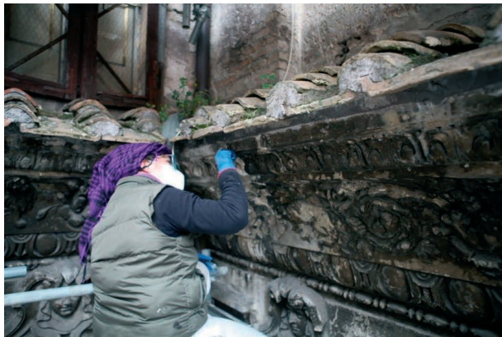
Intervento di pulitura sul cornicione dell'ultimo piano
