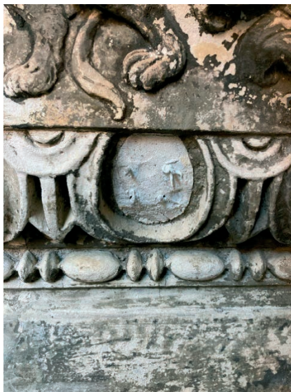
Una fase della lavorazione con la ricostruzione di un ovulo
