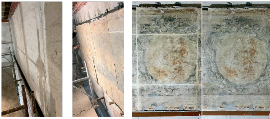
Parete prima e dopo il montaggio
