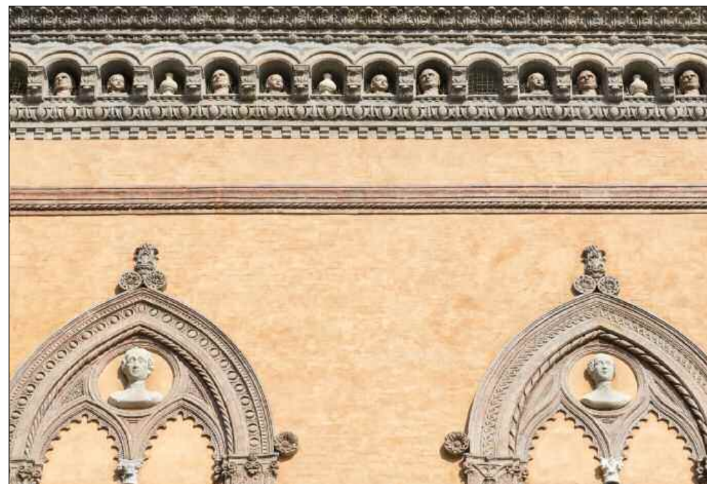
Palazzo Bolognini Isolani, particolare della facciata.
